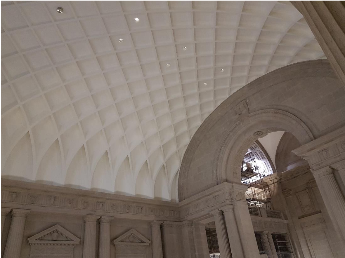
Abb. 1 Quelle: Vogl Deckensysteme GmbH Trockenbau in Höchstform: Dieses katedralähnliche Gewölbe über dem zentralen Treppenhaus des historischen Gebäudes wurde neu in Trockenbauweise errichtet.
