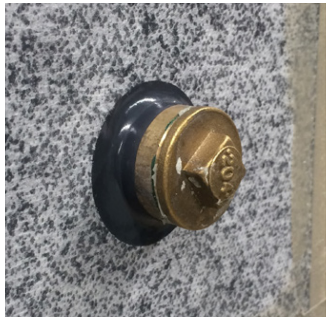
Praxisbeispiel: Rohrdurchführung mit Dichtmanschette
