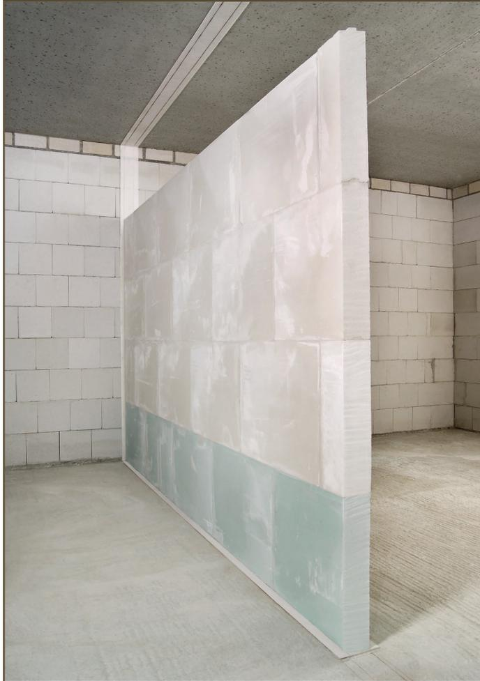
Zur Herstellung elastischer Anschlüsse werden Randanschlussstreifen zwischen Wand und angrenzenden Bauteilen dichtgestoßen und hohlraumfrei eingebaut.
