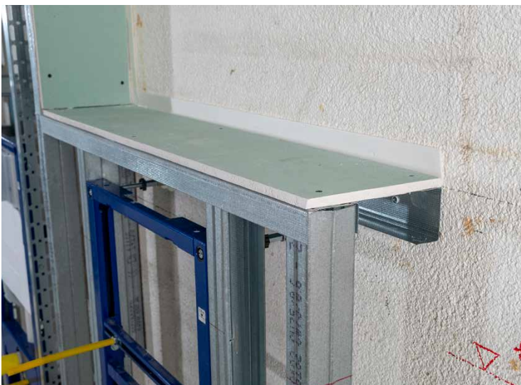
Abb. 10 Beispiel Ausbildung der oberen Abdeckung einer halbhohen Vorsatzschale
