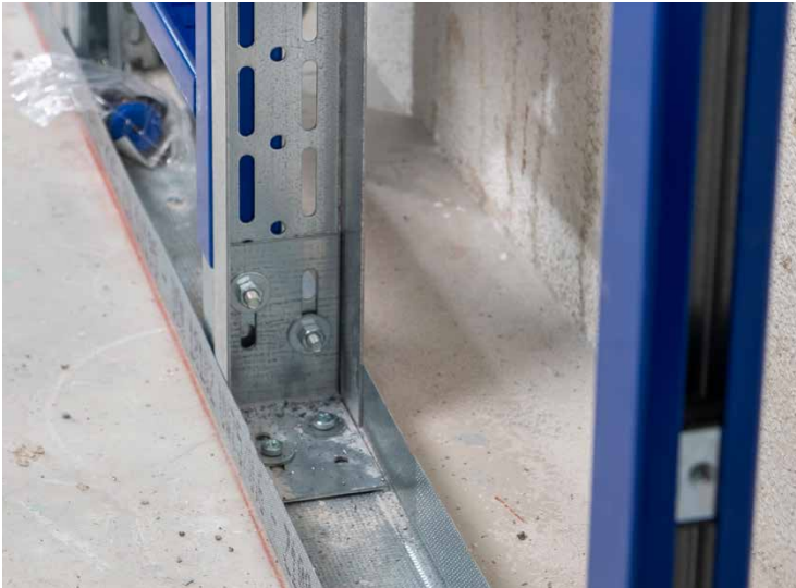
Abb. 9 Beispiel einer kraftschlüssigen Befestigung von UA-Profilen mit Anschlusswinkel am Rohfußboden
