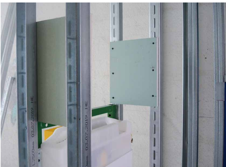
Abb. 11 Beispiel Verlaschung einer Doppelständerwand mit Gipsplattenstreifen
