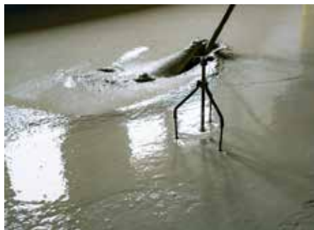
Abb. 1: Nivellierbock zur Einhaltung des geplanten Höhengniveaus
