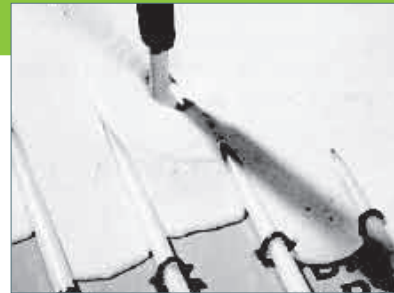
Schon beim Gießen ist es offensichtlich: Durch seine fließfähige Konsistenz umschließt der Fließestrich die Heizleitungen vollständig und homogen – ganz ohne Hohlräume.
