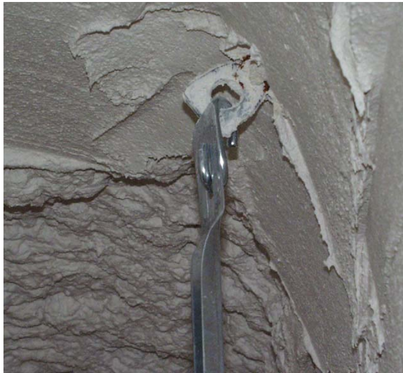
Farbabb. 6: Verzinkter hochfester Bolzen in Kontakt mit Gips bei ausreichender Austrocknungsdauer des Brandschutzgipses
