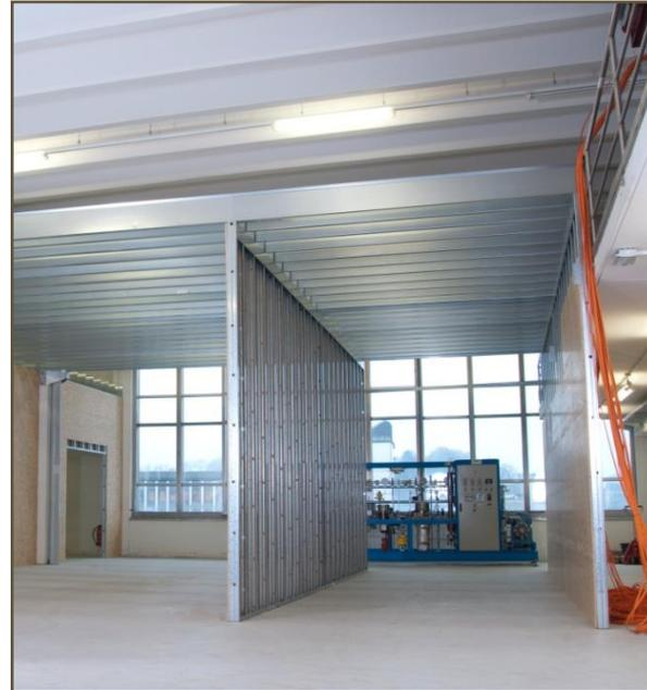
Freigespannte Deckensysteme mit Weitspannträgern sind wichtige Konstruktionen des Stahlleichtbaus. Mit ihnen werden selbstständige Raumsysteme erstellt.
