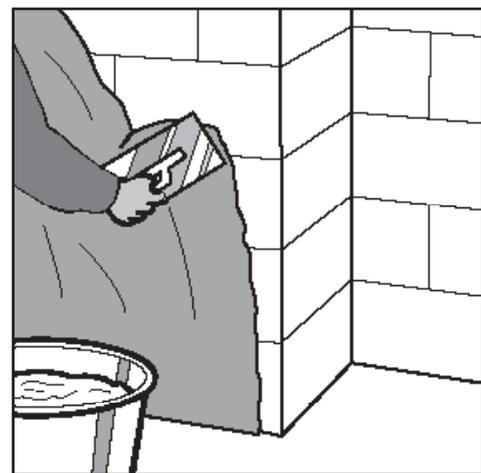
Bei Schornsteinwangen wird eine nicht-brennbare Ansetzbinder- oder Kleberschicht vollflächig auf das Mauerwerk aufgezogen und die Platte hohlraumfrei hineingedrückt.
